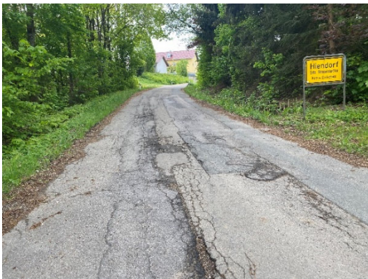
Abbildung 6: Nördliches Ende der Dorfstraße mit Schadstellen
