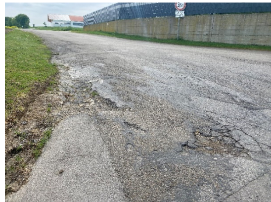
Abbildung 7: Kreuzung Hölzlweg/Dorfstraße mit Schadstellen
