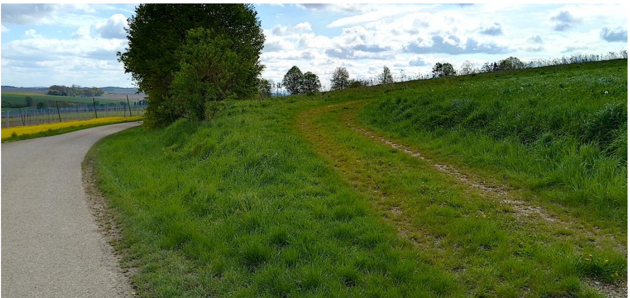
Abbildung 6: Auffahrt von der Verbindungsstraße zur Teilfläche 2 nördlich der Straße; (Foto: Bachmann Artenschutz GmbH)
